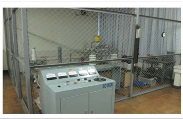
【高電圧を発生する装置】
